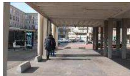
Sous-face de dalle béton armé à nervures
