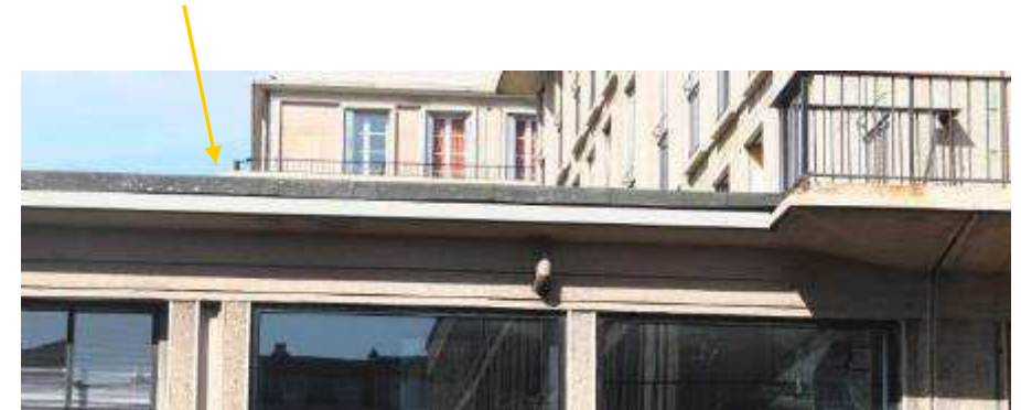
Débord de l'étanchéité visible en façade
