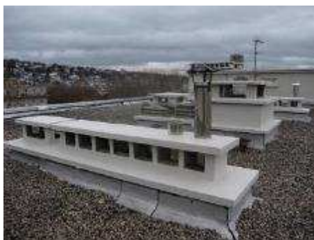
Terrasses gravillonnées claires – bitumée noire – gravillonnée colonisée
