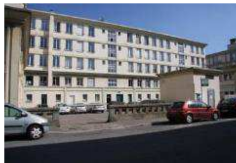
N5 Seuil balustrade béton rue d'Estimauville
