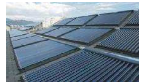
Capteurs solaires thermiques par tubes sous vide pouvant être posés à plat
