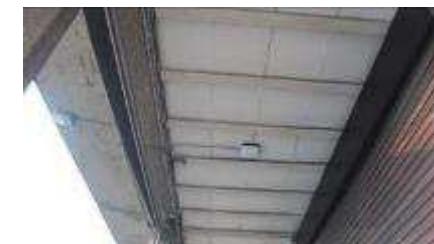
Sous-face de dalle béton armé à nervures
