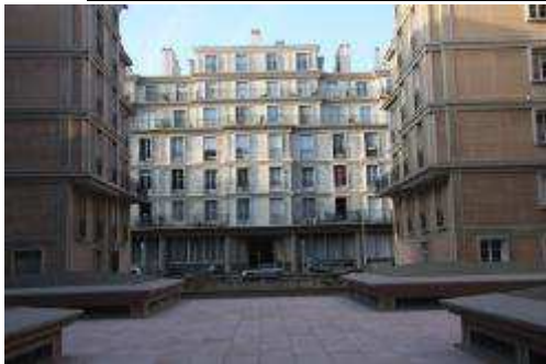
Cour V27 : cour minérale sur dalle (rue Béranger)
