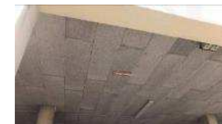
Isolation venant buter contre la poutre de rive
