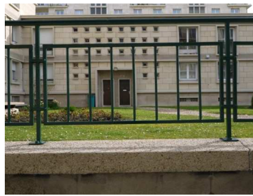
Exemple de garde-corps – V2 rue de Caligny
