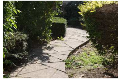
Sentier traversant en béton façon opus
