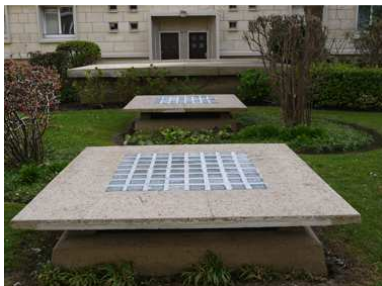
Exemple de puits de lumière sur dalle – Ilot V2 rue de Caligny
