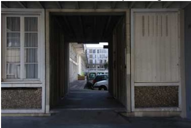
Exemple de passage ouvert
