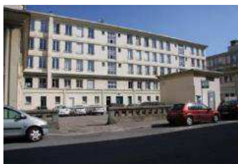
N5 Seuil balustrade béton rue d'Estimauville
