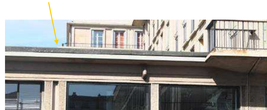
Débord de l'étanchéité visible en façade
