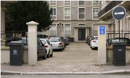
Exemple de seuil d'entrée en pavé de grès récupérés et de revêtement de cour en béton caillouté rue d'Esmauville (qualité de la clôture)
