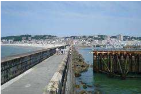
Digue Nord: Belvédère sur le centre reconstruit
