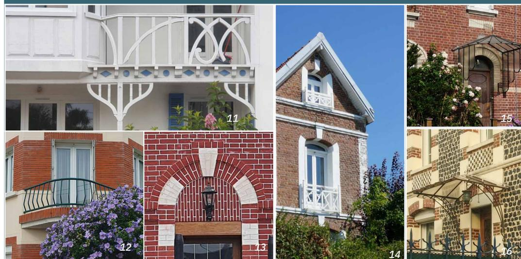
(11) Garde-corps ouvragé en bois - (12) Garde-corps métallique en courbes - (13) Lanterne - (14) Garde-corps ouvragé en bois - (15) (16) Marquises en fer forgé
