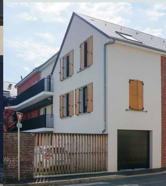
Pour une clôture neuve, des matériaux « nobles » peuvent être mis en œuvre en parement d'un mur en parpaings. Cette solution est moins coûteuse qu'une maçonnerie réalisée de façon traditionnelle. Les clôtures peuvent être en bois laissé brut, qui prendra naturellement une teinte grisée-argentée avec le temps. Léger et facile à mettre en œuvre, le bois présente une grande variété d'agencement et de finitions possibles.
