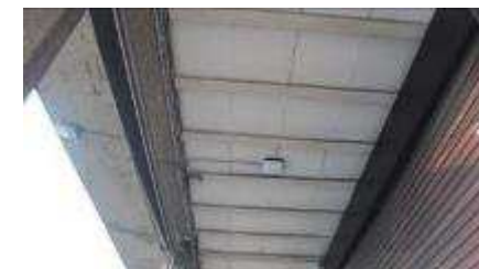
Sous-face de dalle béton armé à nervures
