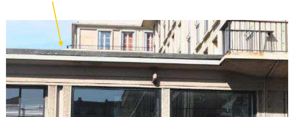
Débord de l'étanchéité visible en façade
