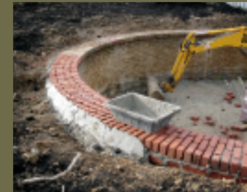
Travaux de maçonnerie
