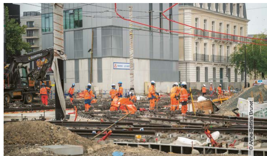
Secteur gare, les travaux de raccordement de la future ligne C du tramway s'achèvent le 13 septembre.
