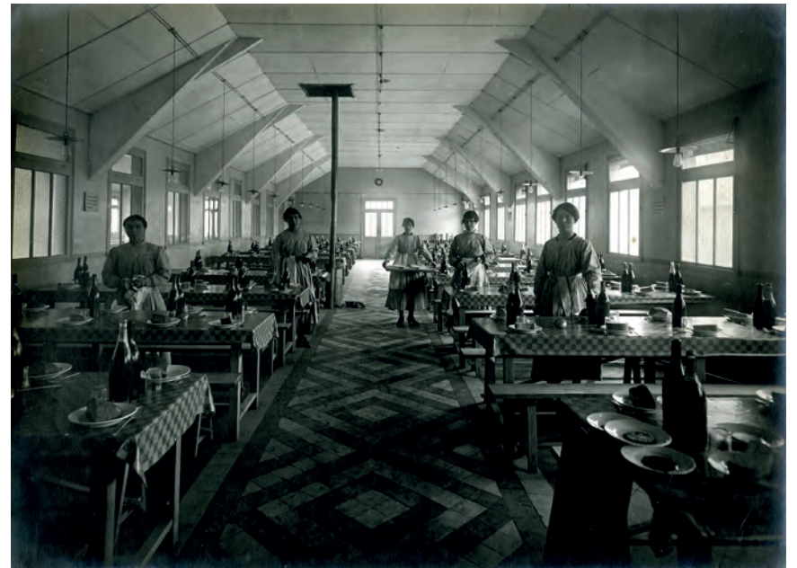
↑ Cantine de l'Usine ANNÉES 10' ARCHIVES MUNICIPALES DU HAVRE [33FI0074]
