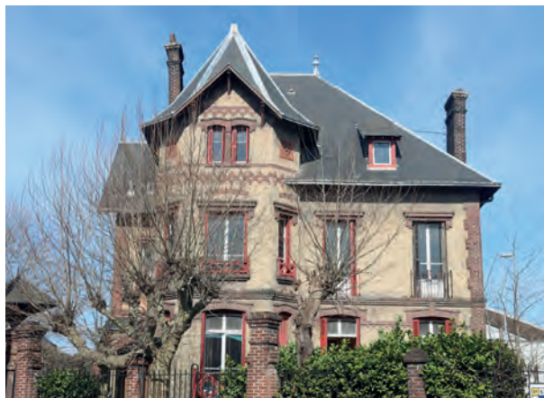
← Maison du Directeur des Tréfleries ANNÉES 2010 DANS LES ARCHIVES DE JEAN-PIERRE LEROUX
