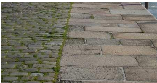
Calepinage de pavés de grés anciens et moellons de granit beige (Quai du Bassin du Commerce)
