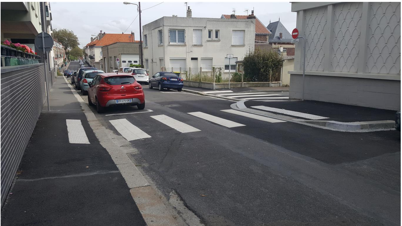
Bateau ou abaissement de trottoir
