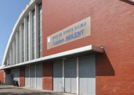
Le Bureau Central de la Main d'Oeuvre (BCMO), Le Havre
