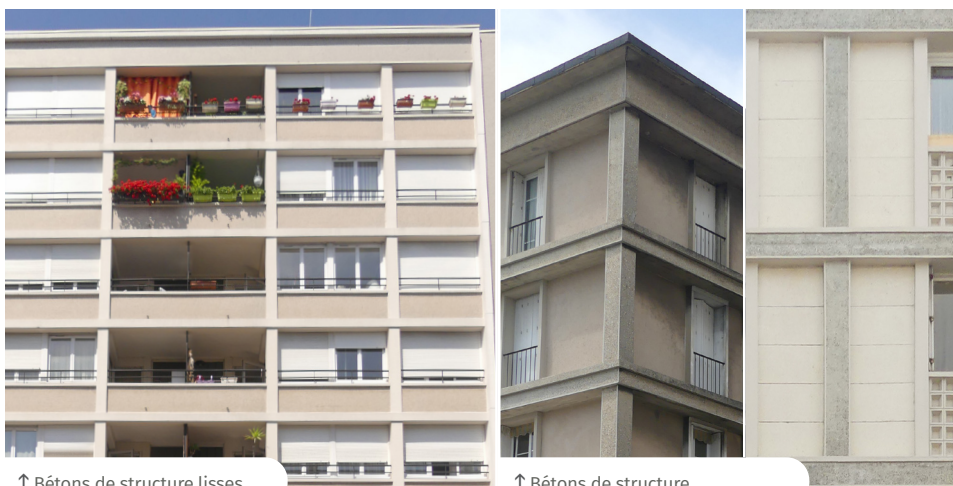
↑ Bétons de structure lisses
