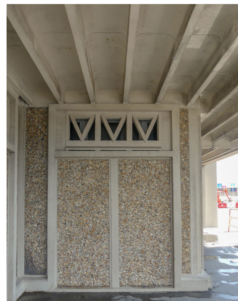
↑ Sous-face de plancher non-isolée
