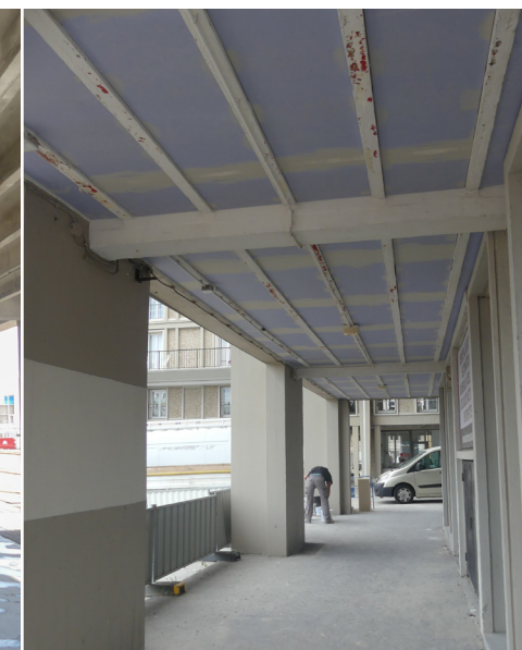
↑ Sous-face de plancher en cours d'isolation
