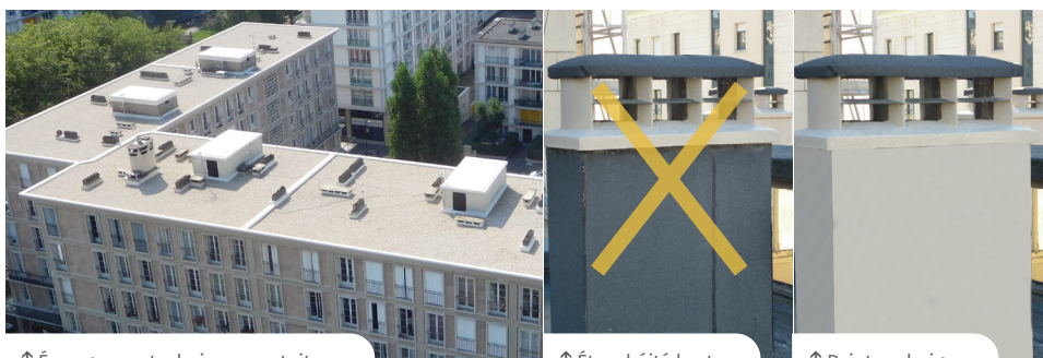
↑ Émergences techniques en toiture
