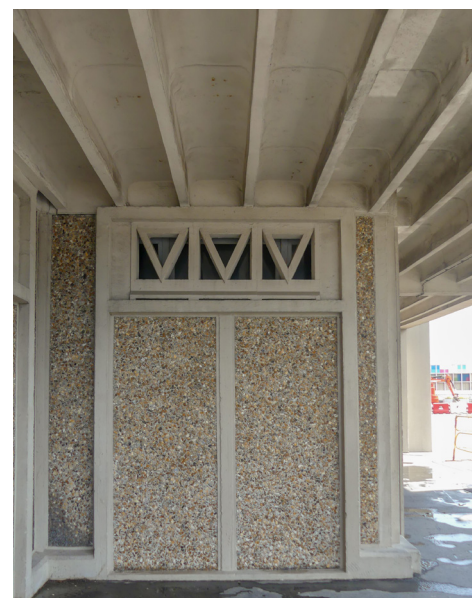
↑ Sous-face de plancher non-isolée
