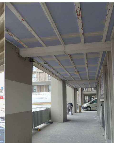
↑ Sous-face de plancher en cours d'isolation
