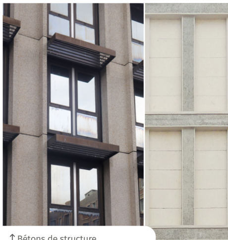
↑ Bétons de structure
