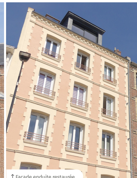
↑ Façade enduite restaurée
