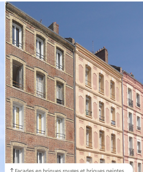
↑ Façades en briques rouges et briques peintes
