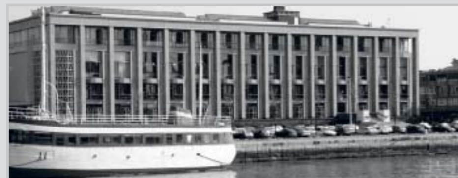
3-23. Chambre de Commerce et d'Industrie (quai George V)
