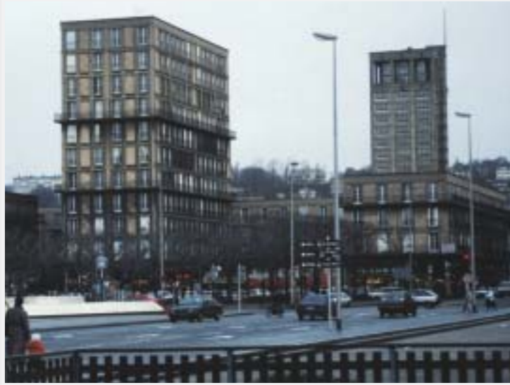
4-27. La ville avant le ravalement des immeubles
