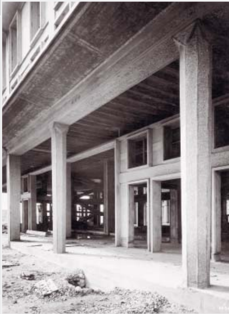
3-58. Chantier immeuble rue de Paris
